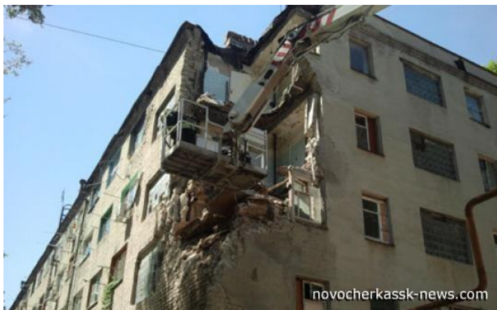
Рис. 8. Обрушение перекрытий и стен пятиэтажного жилого здания в г.Новочеркасске
