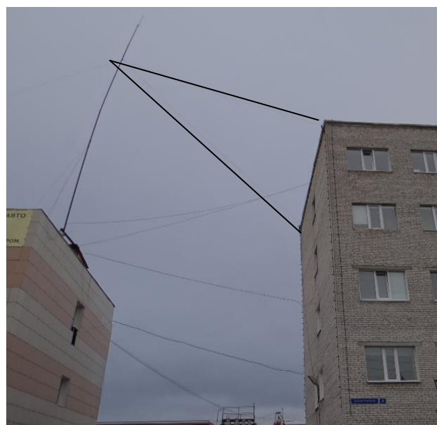
Рис. 5. Крепление оттяжек антенны к парапету административного здания
