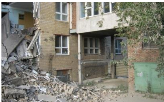
Рис. 11. Обрушение части четырехэтажного корпуса Политехнического института Сибирского федерального университета в г.Красноярске
