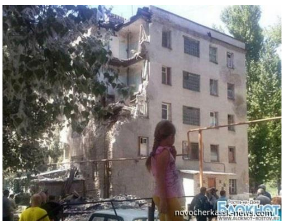
Рис. 8. Обрушение перекрытий и стен пятиэтажного жилого здания в г.Новочеркасске
