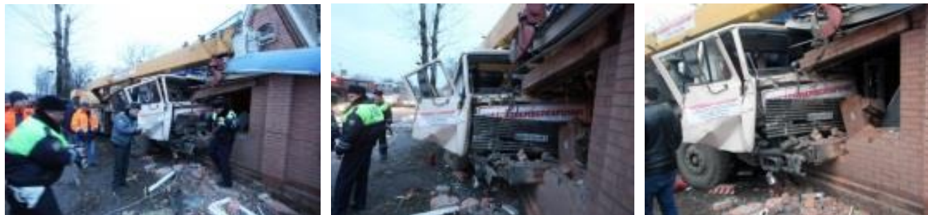
Рис. 12. Обрушение стена магазина в г.Ростов-на-Дону
