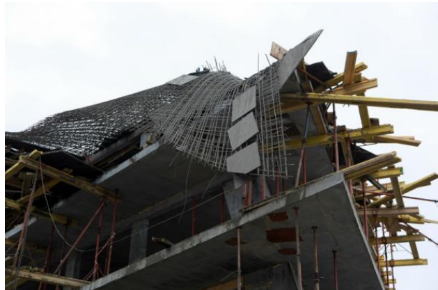
Рис. 5. Обрушение конструкций строящегося общественно-делового центра г.Архангельске
