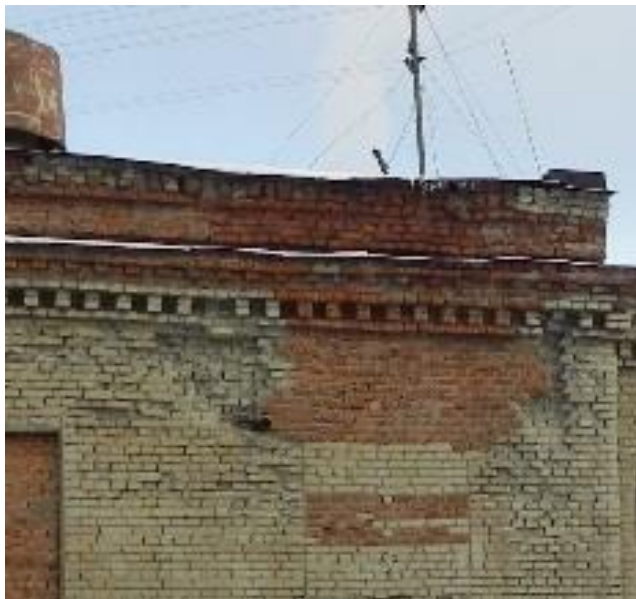
Рис. 6. Кирпичное здание после проведения ремонтно-восстановительных работ
