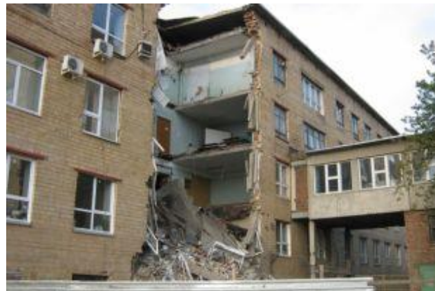
Рис. 11. Обрушение части четырехэтажного корпуса Политехнического института Сибирского федерального университета в г.Красноярске
