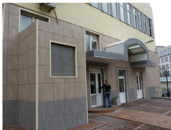
Внешний вид штыревого навесного вентилируемого фасада
