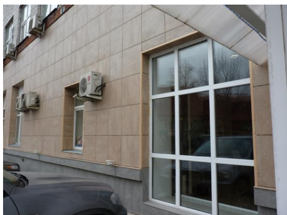
Внешний вид штыревого навесного вентилируемого фасада
