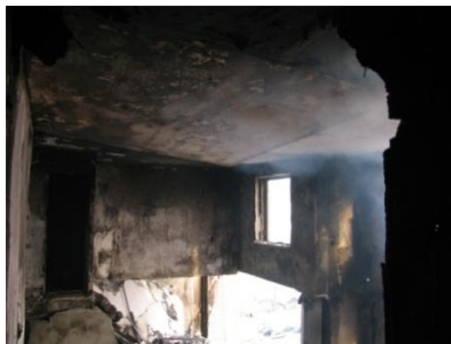
Рис. 2. Состояние несущих конструкций здания после взрыва
