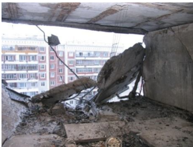
Рис. 2. Состояние несущих конструкций здания после взрыва
