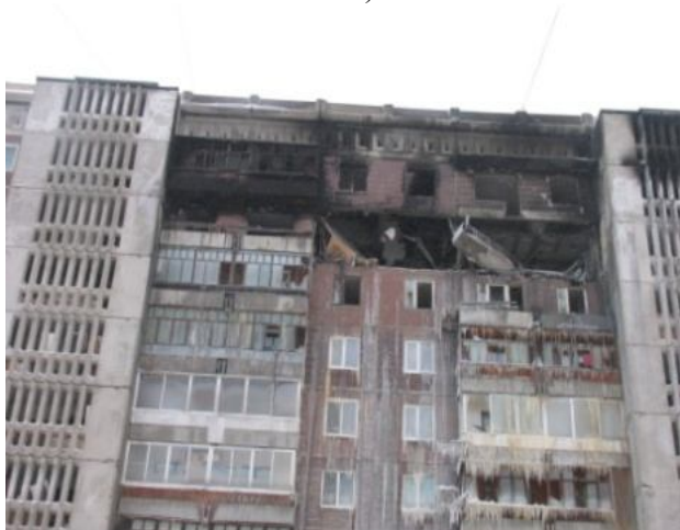
Рис. 1. Фрагмент фасада здания по осям «Вс» (а) и «Ас» (б) после взрыва
