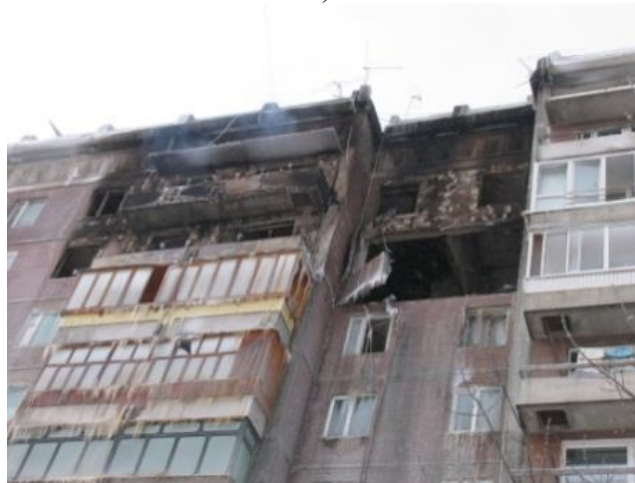
Рис. 1. Фрагмент фасада здания по осям «Вс» (а) и «Ас» (б) после взрыва
