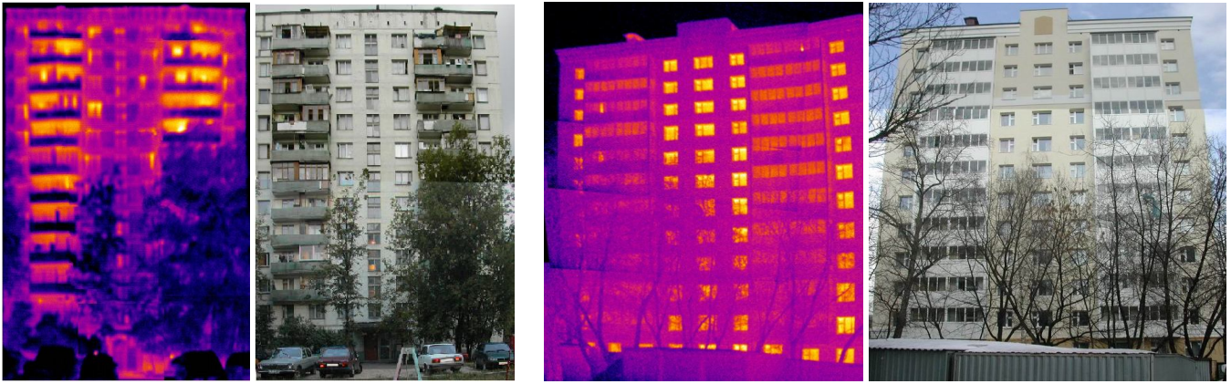
Рис. 13. Санация старого жилого фонда (До реконструкции R_{пр}=1,1 (\pm 15\%) , после реконструкции R_{пр}=3,0 (\pm 15\%) )
