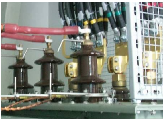
Рис. 15. Электросетевое хозяйство. Трансформаторная подстанция. Идентификация перегретых контактов
