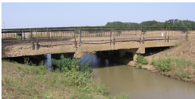
Рис. 1. Общий вид мостового переезда через Право-Егорлыкский канал
