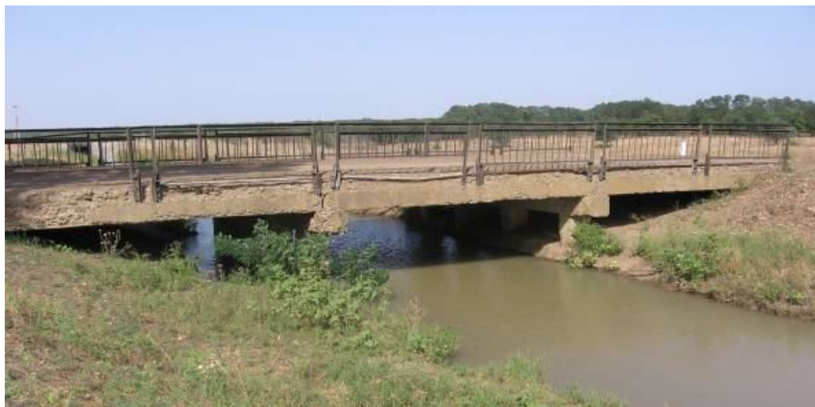
Рисунок 1 – Общий вид мостового перехода через Право-Егорлыкский канал
