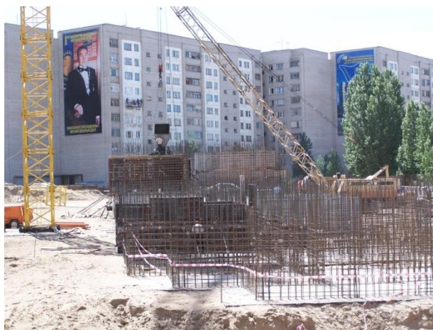
Рис. 10. Строящееся здание из монолитного бетона
