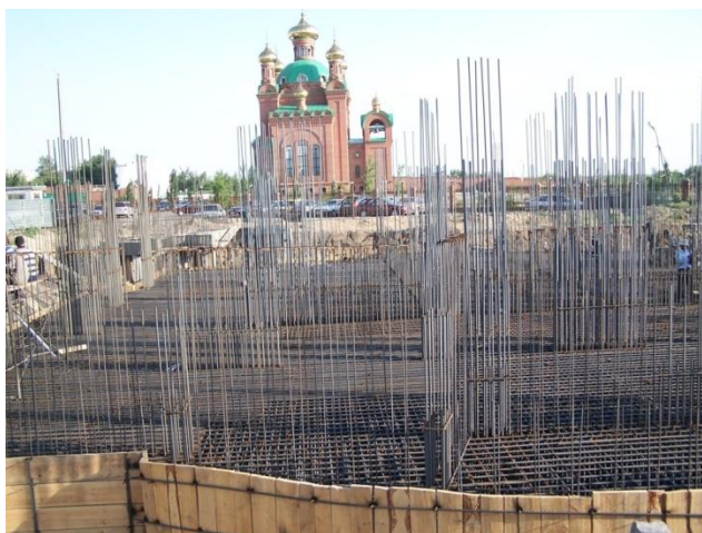
Рис.9. Строящееся административное здание
