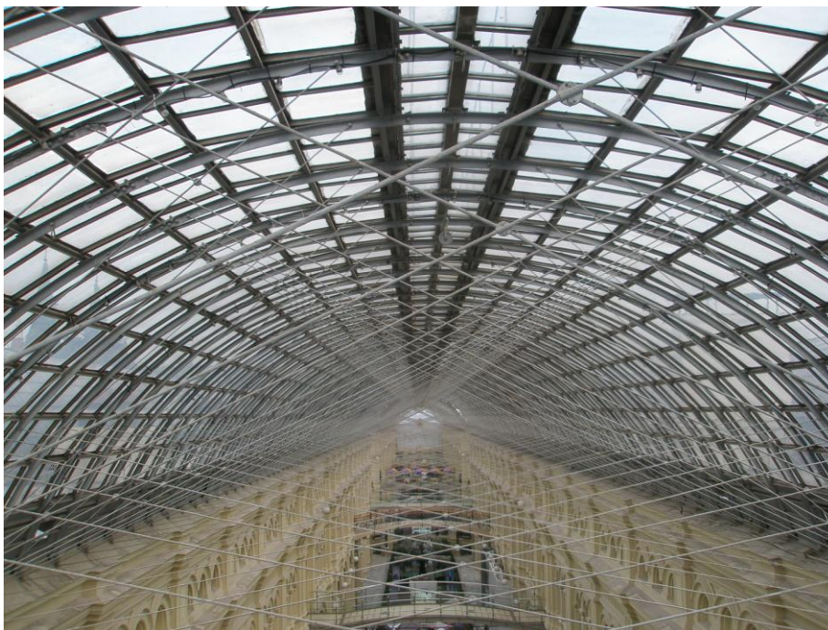
Рисунок 1 – Общий вид сводчатого покрытия
