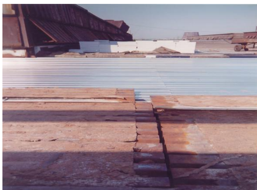
Рис. 3 - Укладка настила без нахлестки
