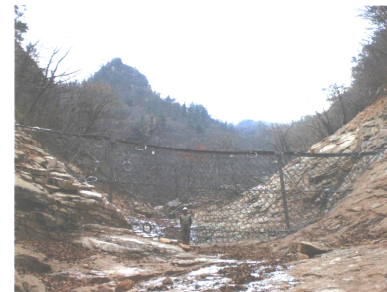
Рис.3. Гибкий многоуровневый селевой барьер до прохождения селя.
