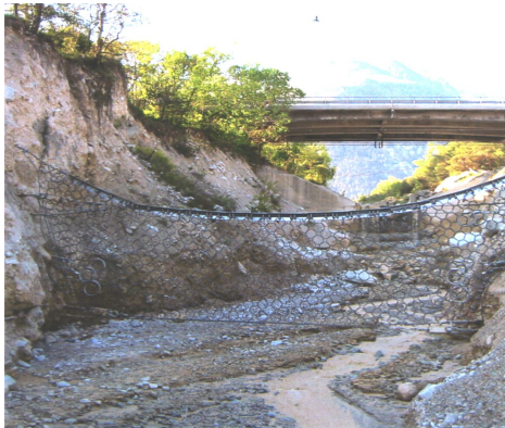
Рис. 2. Пропуск меженного расхода под селезащитным барьером.
