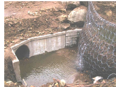
Рис.4. Гибкий многоуровневый селевой барьер после прохождения селевого потока.
