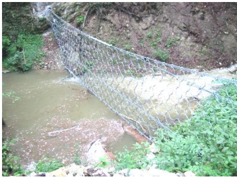
Рис. 1. Гибкие многоуровневые селезащитные барьеры.
