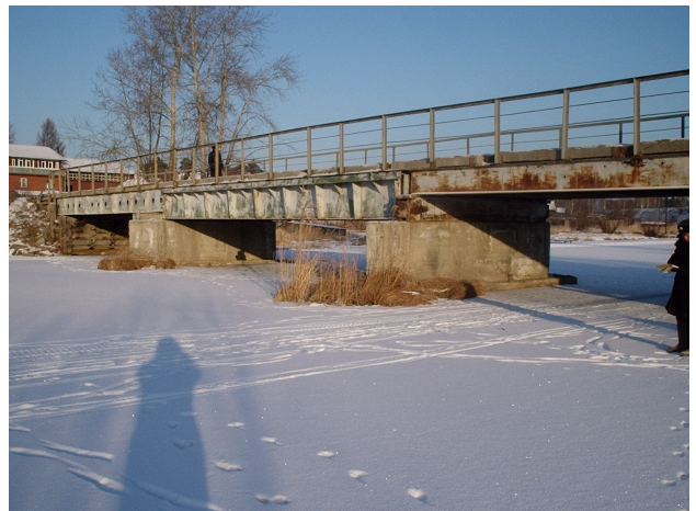
Рис. 1. Общий вид существующего моста
