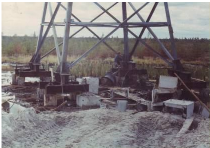
Рис. 2. Рабочий момент усиления свайных фундаментов опор ЛЭП
